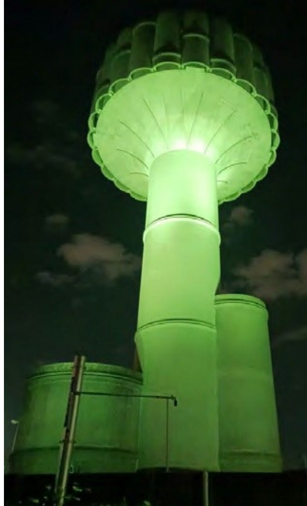
京都府 向日市上植野浄水場配水塔（かぐやの灯） （本会で撮影）
