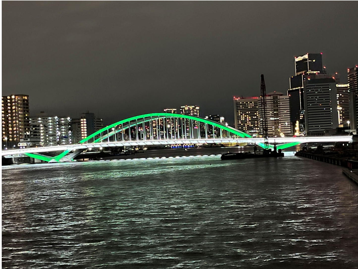
東京都 築地大橋
